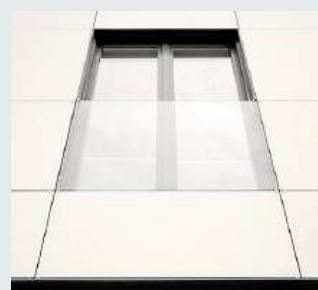
Die Fenster sorgen für optimales Tageslicht.
